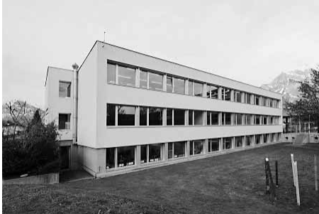
Schulhaus Kleinfeld West
