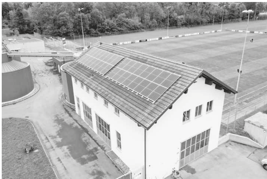
Blick auf die Photovoltaik-Anlage auf dem Schlammbehandlungsgebäude der ARA
