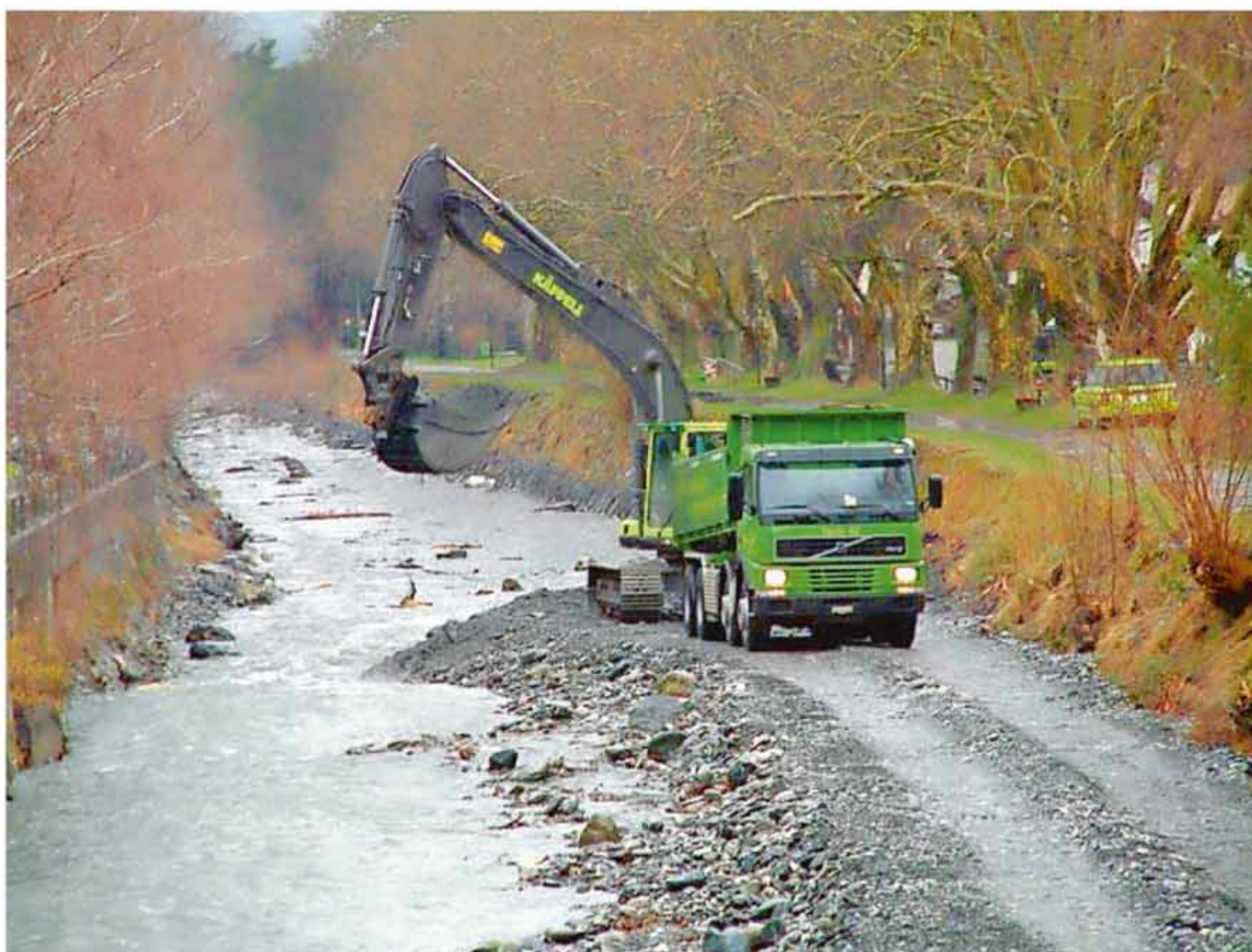
Ausbaggerung Taminagerinne im März 2004
