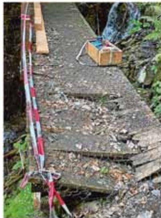
Die Brücke wurde durch ein Steinschlagereignis und umgestürzte Bäume beschädigt.
