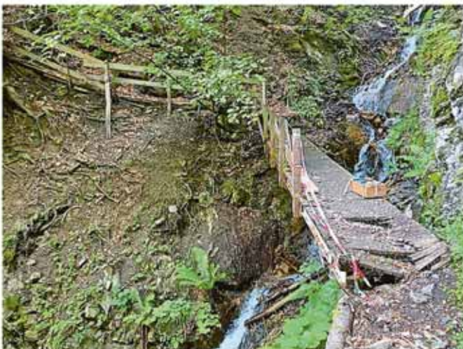
Die Brücke wurde durch ein Steinschlagereignis und umgestürzte Bäume beschädigt.
