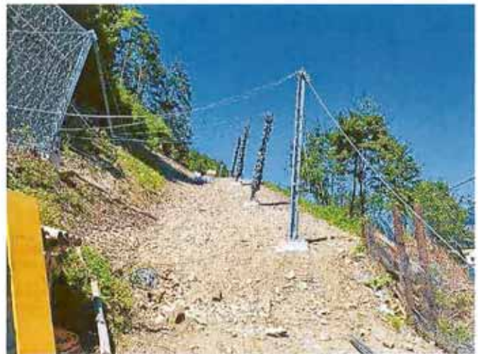
Installation Netzstützen
