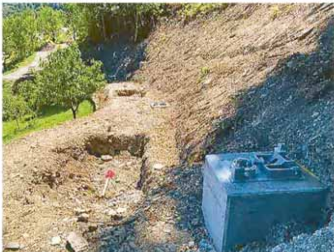
Fundamente für Netzstützen
