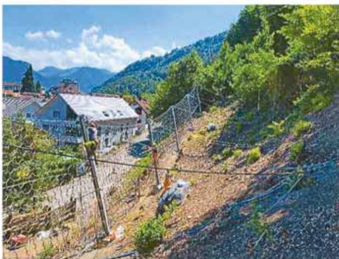
Montage Steinschlagschutznetze
