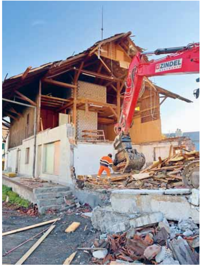
Abbildung 10: Rückbau ehemalige Landi
