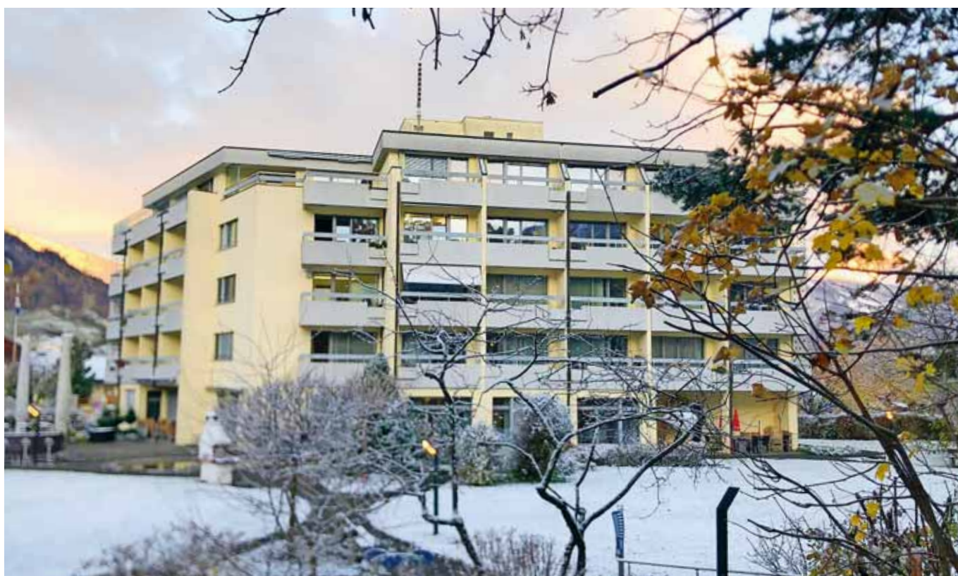
Abbildung 26: Altersheim Allmend, Aussenansicht
